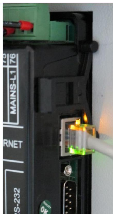
Установка кронштейна самостопорящего типа
